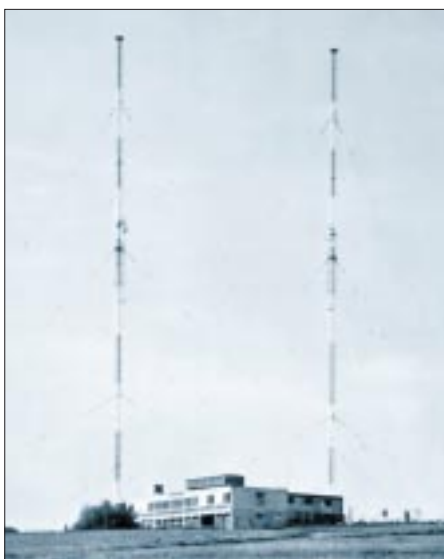
Sendetürme des Mittelwellen-Großsenders der Europawelle Saar Heusweiler, der tagsüber mit 1200 kW, nachts mit 600 kW sendete Foto: Europawelle Saar
